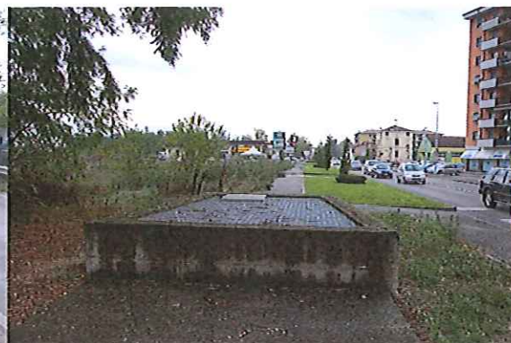
Vista di Via Palazzina verso San Giovanni Lupatoto
